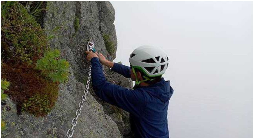
鎖点検作業中
