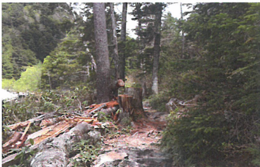
0529 横尾～一ノ俣 倒木処理 (作業後)
