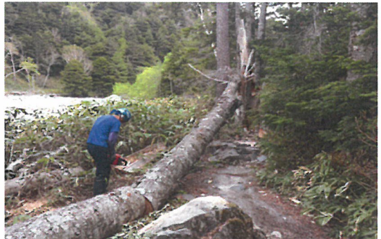
0529 横尾～一ノ俣 倒木処理 (作業中)
