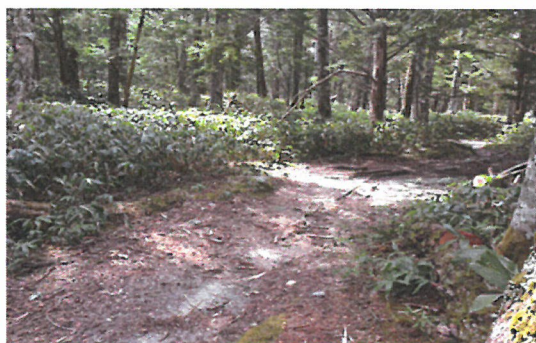
0518 横尾～一ノ俣 倒木処理 (作業後)
