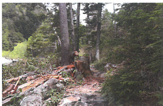
0529 横尾～一ノ俣 倒木処理 (作業後)
