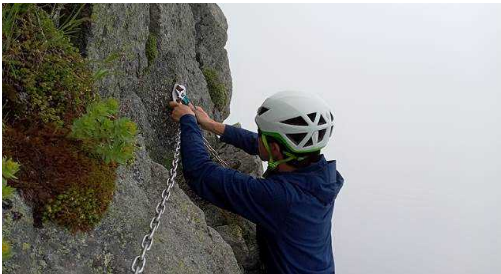
鎖点検作業中
