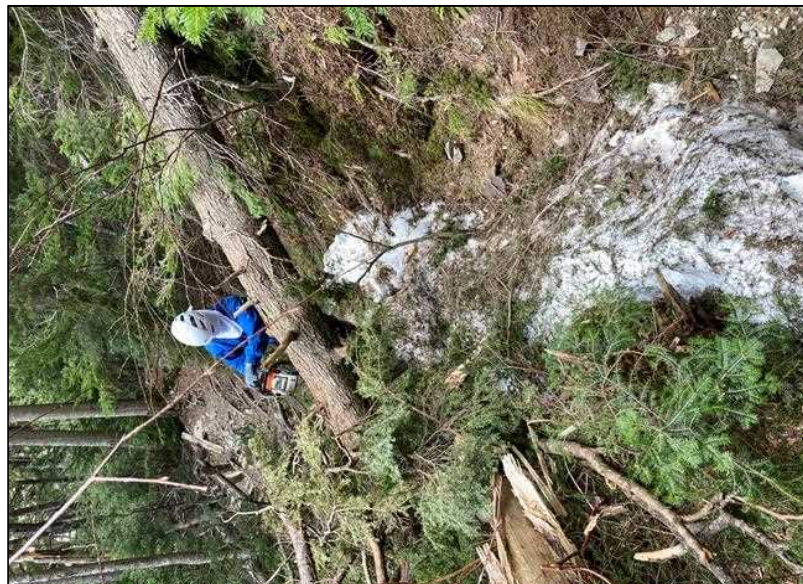
倒木除去作業中
