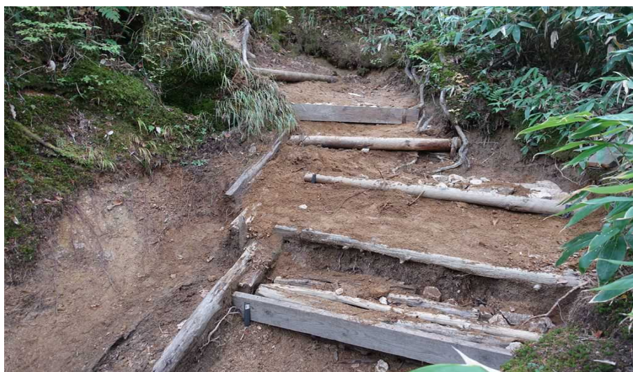
階段修繕作業（作業後）
