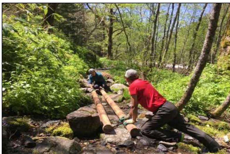
ぬかるみ対策作業（作業中）
