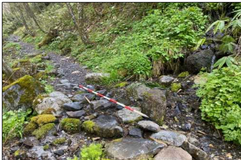
ぬかるみ対策作業（作業前）
