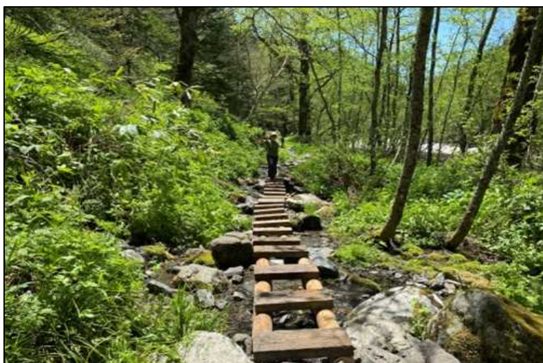
ぬかるみ対策作業（作業後）
