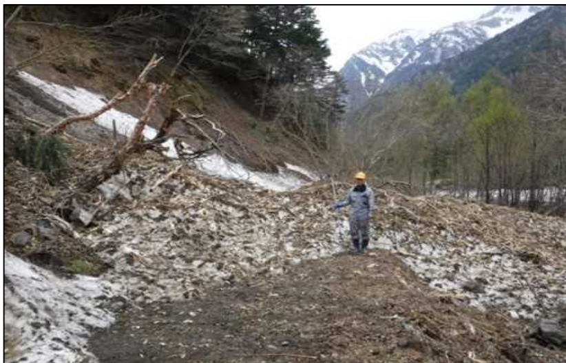
除雪、崩落除去、路面整備（作業前）
