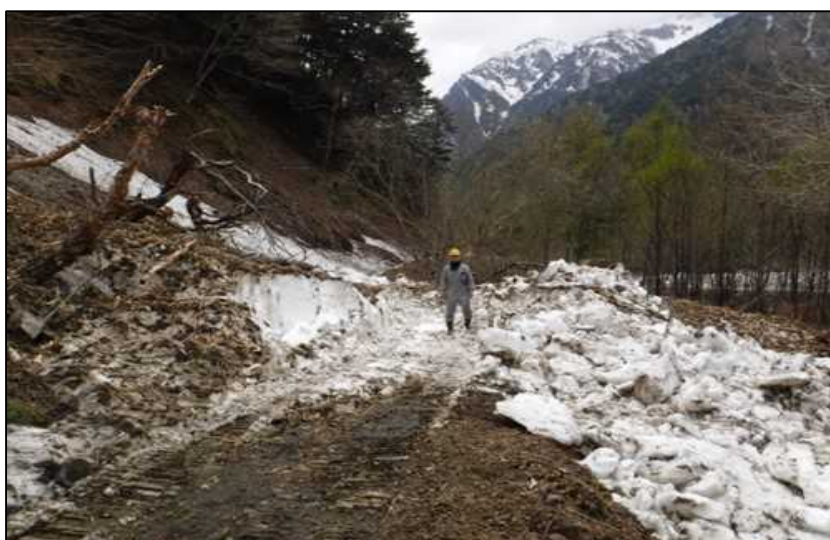
除雪、崩落除去、路面整備（作業後）
