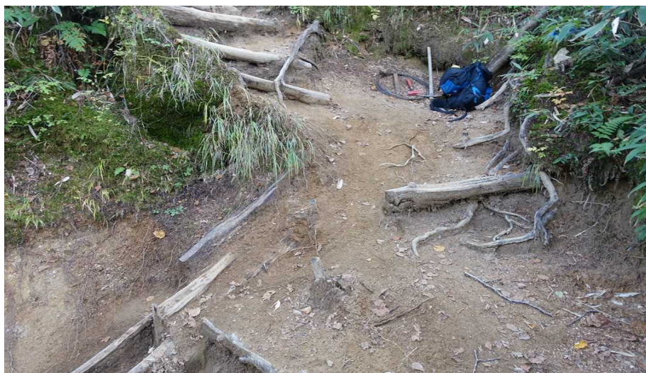
階段修繕作業（作業前）
