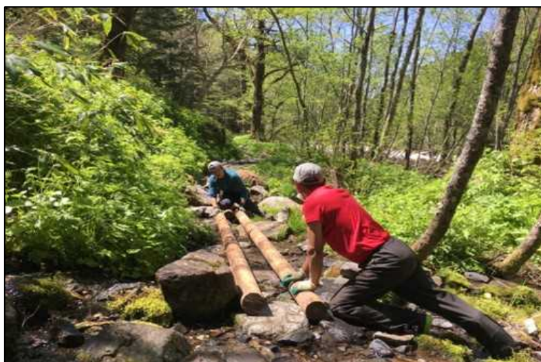
ぬかるみ対策作業（作業中）
