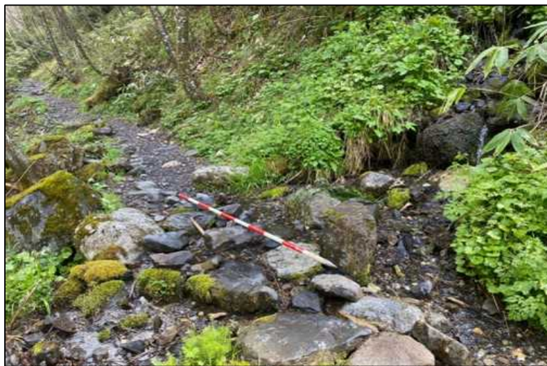
ぬかるみ対策作業（作業前）
