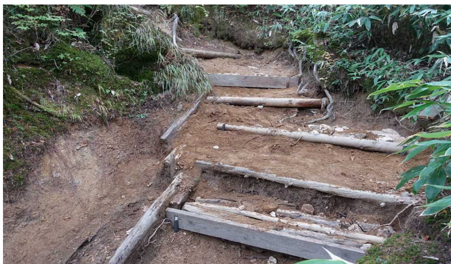
階段修繕作業（作業後）
