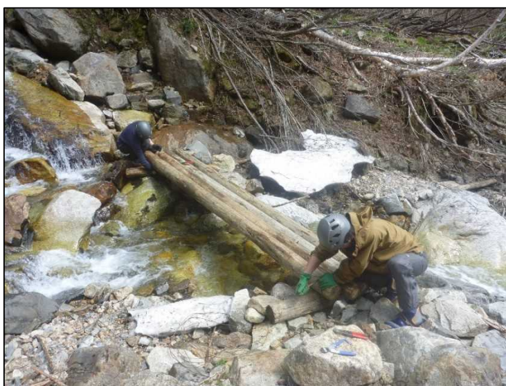
石積・木橋架け（作業中）
