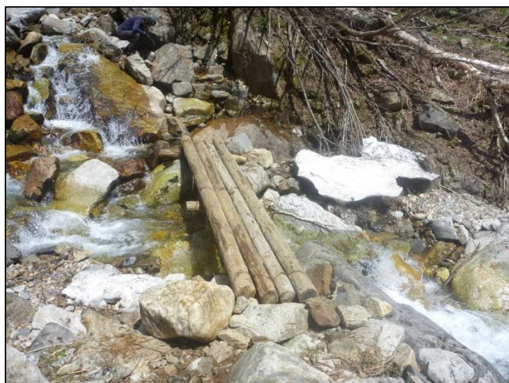
石積・木橋架け（作業後）
