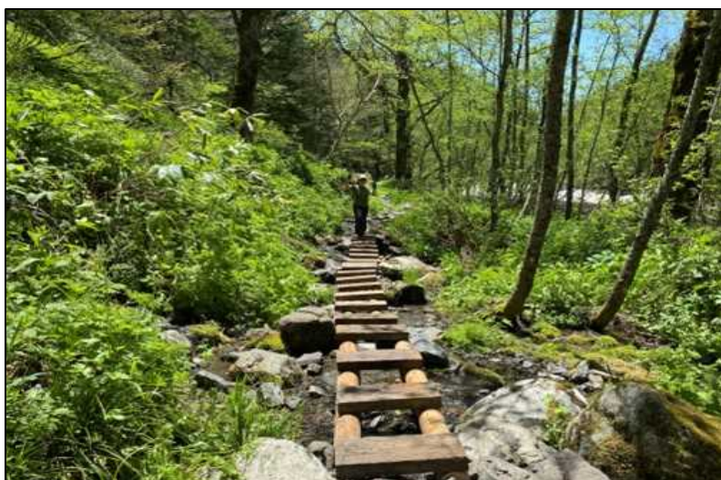
ぬかるみ対策作業（作業後）
