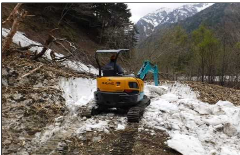
除雪、崩落除去、路面整備（作業中）
