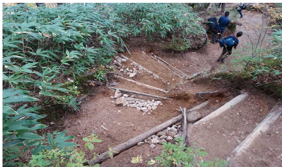
階段修繕作業（作業後）
