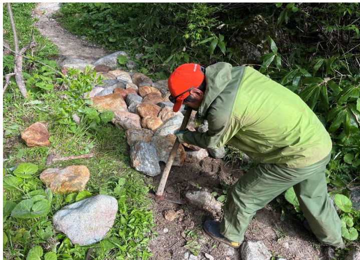
石積作業（作業中）
