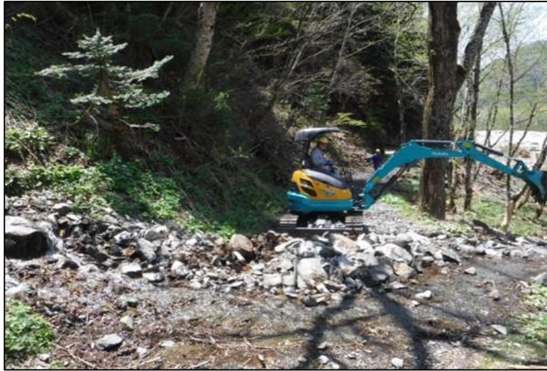
出水による流出土砂除去、路面整備（作業前）
