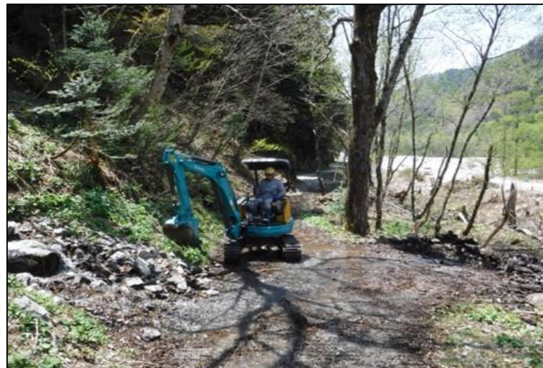
出水による流出土砂除去、路面整備（作業中）
