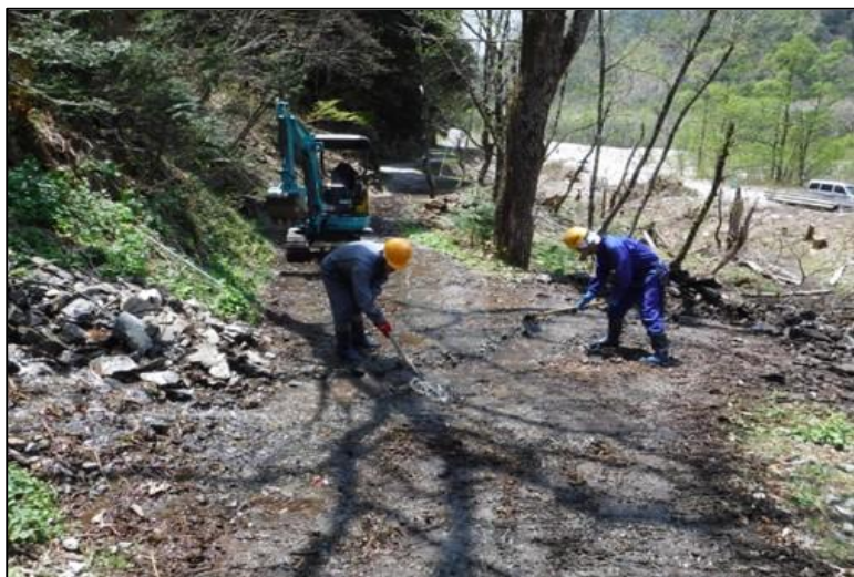
出水による流出土砂除去、路面整備（作業後）
