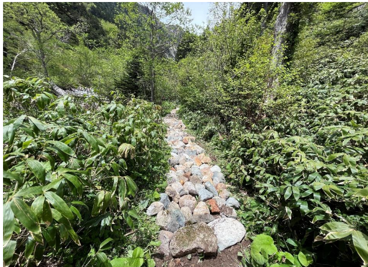
石積作業（作業後）
