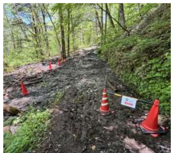
出水による流出土砂除去、路面整備（作業後）
