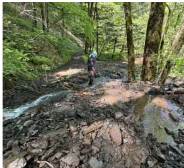
出水による流出土砂除去、路面整備（作業中）
