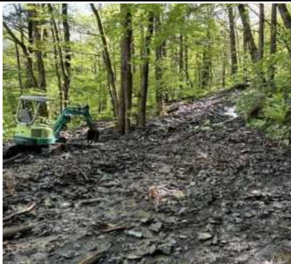
出水による流出土砂除去、路面整備（作業前）
