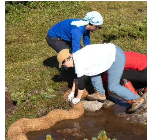
侵食された法面に固定
