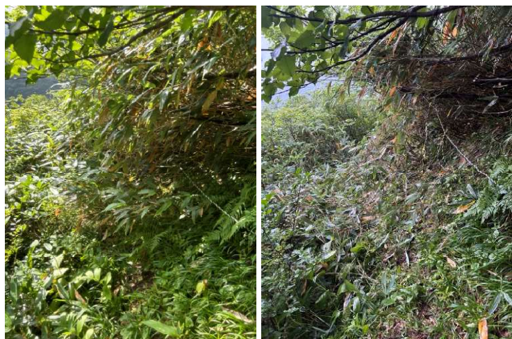
施工前・施工後
