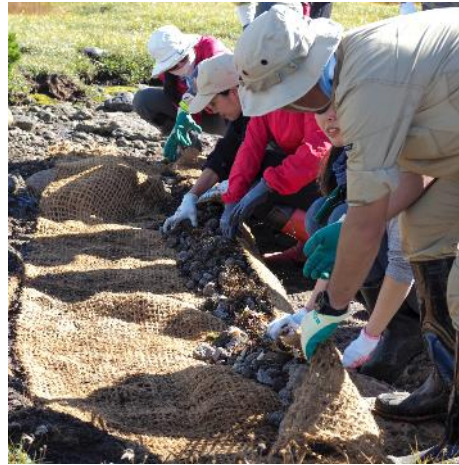
転石を巻き込みながら ネットを海苔巻状に巻く
