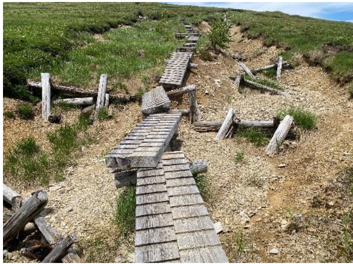
土壌侵食と木道の傾倒
